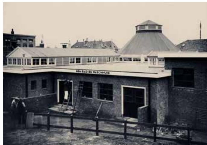
Voorgevel van het 'Gemeentelijk Bad- en Waschhuis' met twee ingangen
